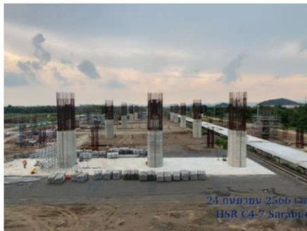
งาน Column สำหรับสถานีรถไฟความเร็วสูง
