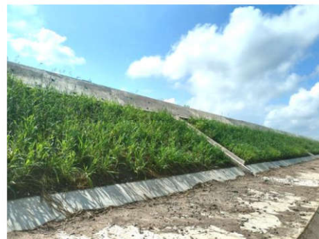
การป้องกันดินพังทลายบริเวณทางวิ่งรถไฟความเร็วสูง
