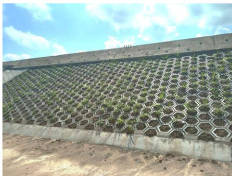
การป้องกันดินพังทลายบริเวณทางวิ่งรถไฟความเร็วสูง
