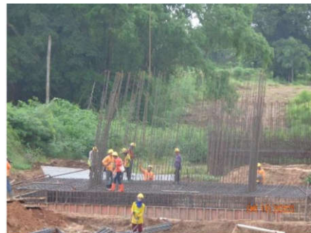
งานผูกเหล็กเสาคอนกรีต
