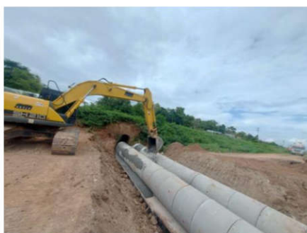
งาน Pipe culverts Dia
