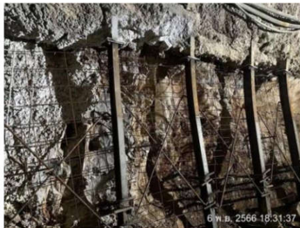
งาน Anchor bolt, steel support
