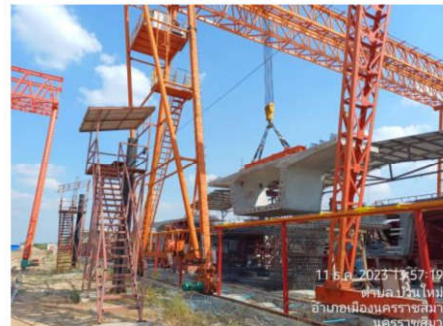
งานตัดเหล็ก ดัดเหล็ก ผูกเหล็ก เทคอนกรีต Segment
