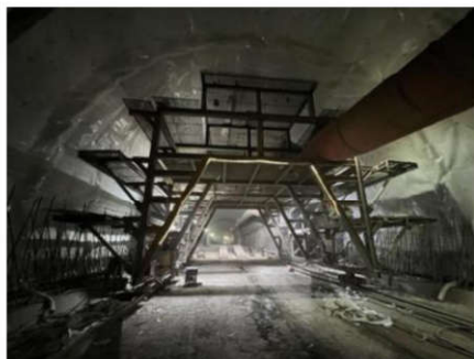
งาน Lining arch wall
