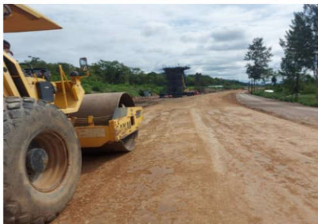
งาน Subbase For Railway
