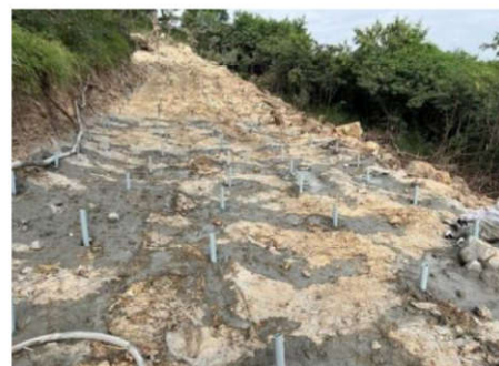
งาน Ground grouting
