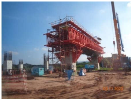
งานติดตั้ง Launcher
