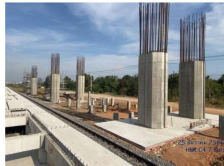
งาน Column สำหรับสถานีรถไฟความเร็วสูง
